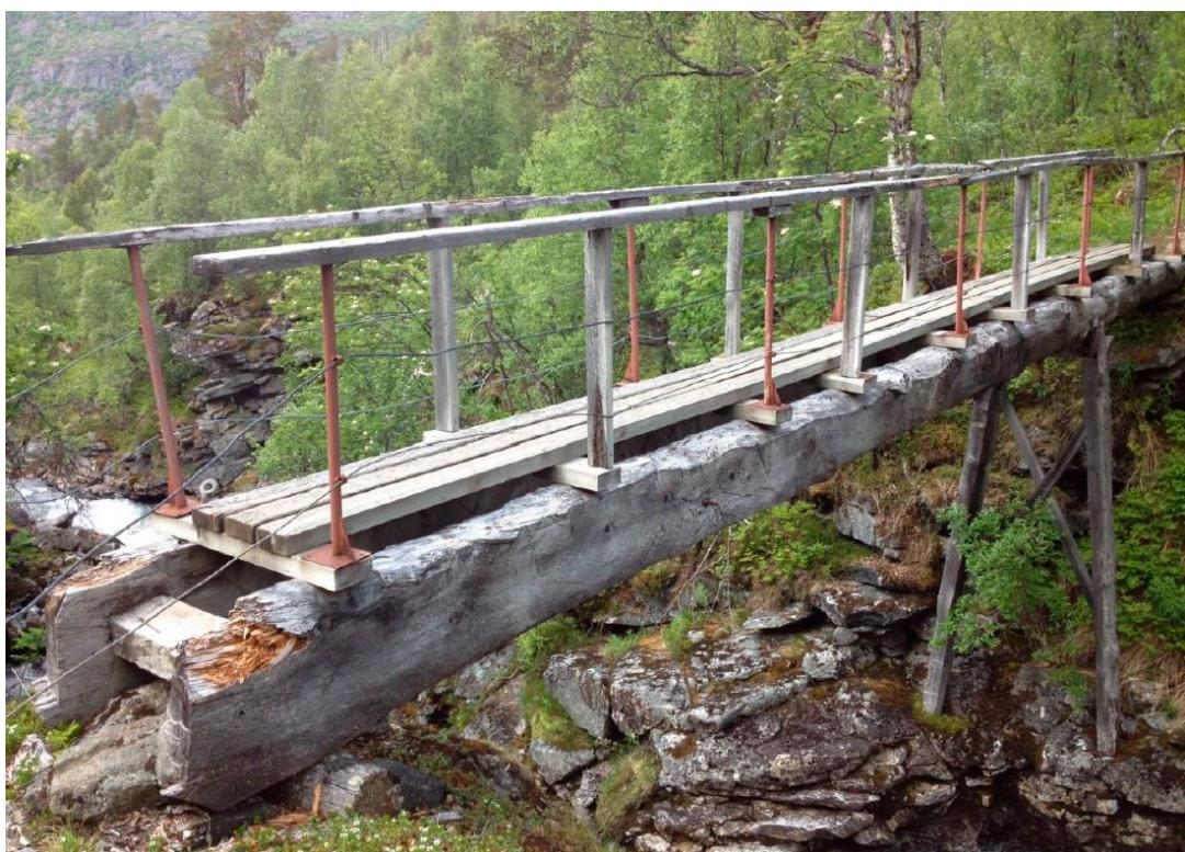
Plan for ny bru: «Ny bru i samme konstruksjonsprinsippet, men i impregnerte materialer. Hovedbæring i 2 stk mastestolper, gangbane i 48/148, rekkverkstolper, diagonaler og håndløper i 48/98 og fot- og knelist i 28/123 mm. Tømmerbukken konstrueres i grove firkantprofiler som stives av diagonalt. Forbindelser utføres med tømmerbindere og gjennomgående bolter. Eksisterende fjellbolter gjenbrukes.»
