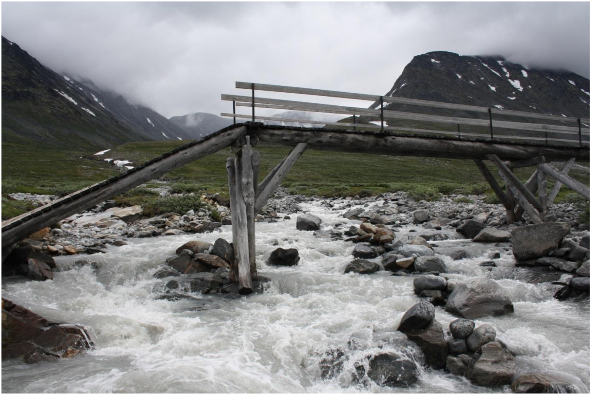
Flytte steiner mot nord på øvre siden av brua.
