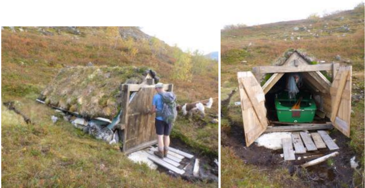
Figur 3: Portane er synlege, men bygget ligg inn i bakken om lag 5 meter ned til vatnet. Inne i bygget er det ikkje golv og berre plass til båten og nokre garn.
