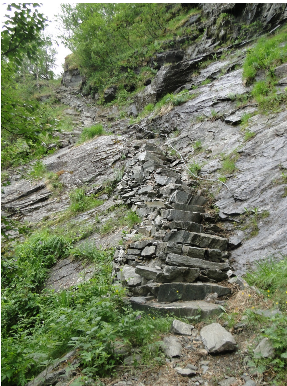
Figur 4.1 Restaurert steintrapp og stålwire til å halde seg i. Foto: O.I. Vistad
