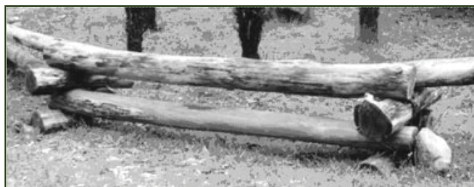
Fig.31: Plassen rammes inn av enkle konstruksjoner som kan bygges av lokalt trevirke. Stokkene kan lett erstattes ved slitasje. Stokkene fungerer også som sittebenker. Man kan sette seg med ryggen mot bilene og ha utsikt mot fossen nedenfor eller fjellene rundt. To ekstra stokker er plassert i det nordvestre hjørnet for å danne en sittekrok ved elva.
