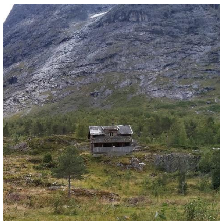
Figur 19: Nedlagt DNT hytte som ikke lenger er i bruk.
