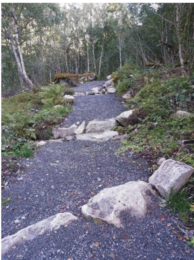
Figur 22: Oppussing av Kuråsa, oppussingen er i gang prosjektet skal ha offentlig åpning 15. Juni 2020. Tilretteleggingsmetoden de går ut ifra er spaltet gurssti.
