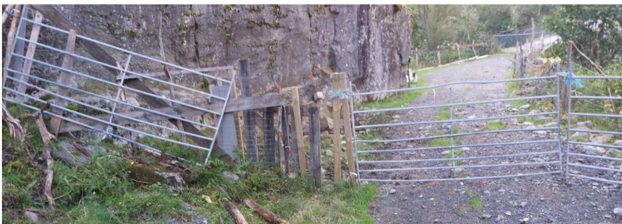
Figur 54: Grinde systemet som brukes i dag er falleferdig og sammensatt av forskjellige typer gjerder og materialrester.
