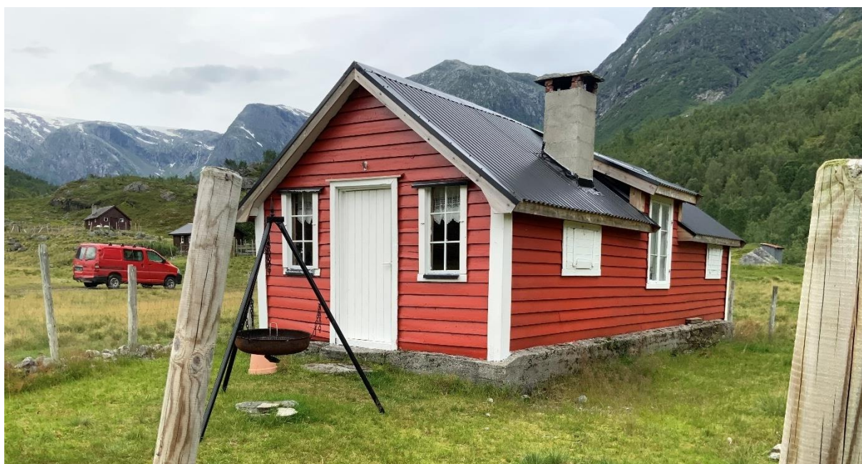
Dette selet på Jarvamyri skal være den eldste bygningen i skjøtselsområdet.
