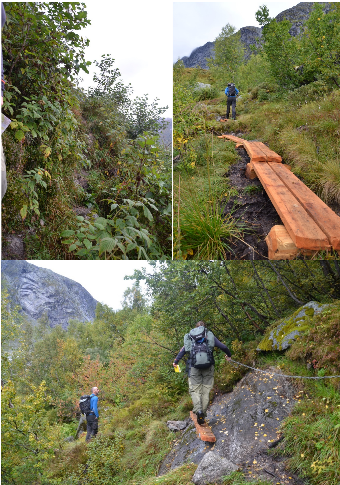
Figur 5.7 I den svært bratte skråninga (ovanfor moreneryggen) går stien i hårnålssvingar, og ved auka ferdsel vil faren for utgliding auke (øvst til venstre). Det er gjennomført fleire tilretteleggingstiltak i 2017 (øvst til høgre, nedst). Foto: Nina E. Eide.
