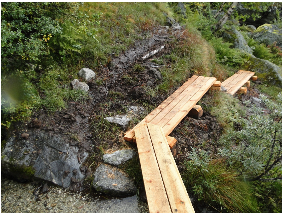
Figur 5.1 Klopplegging opp mot Tufteskaret. Biletet viser slitasje/gjørme som sannsynlegvis vil gro til når kloppane får samla ferdsele. Foto: O.I. Vistad
