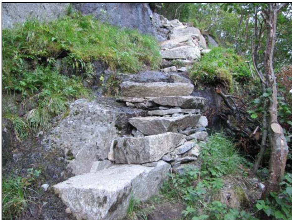
Rett før bekkekryssing 4, "etter-bilde".
