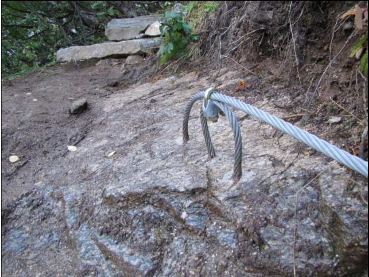
Solid wire med løkke som mellomforankring.
