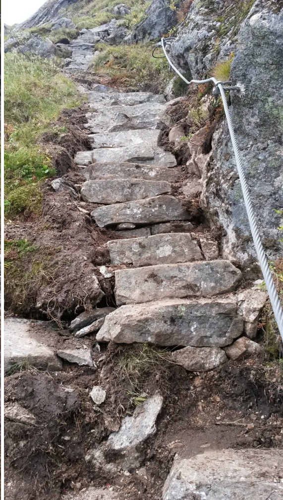
Frå øvre parti vi mura opp i 2015. Inkludert dei gamle trappene som er mura opp, er den bratte strekninga i øvre del no samanhengande utbeta over ein distanse på over 100 meter. Ny og betre wire er også komen på plass.
