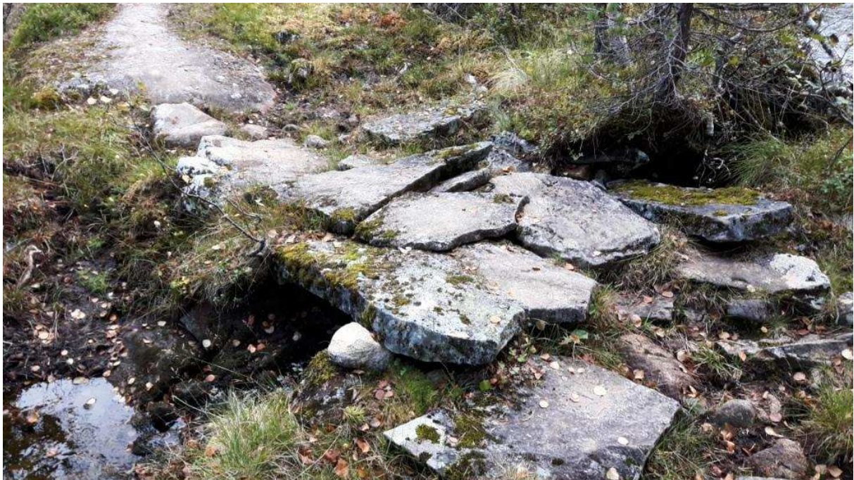
Sundalen. Gammal stikkrenne langs drifteveg.
