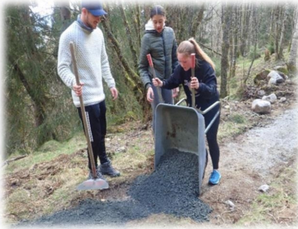
Utkøring av topplag med minidumper eller manuelt med trillebåre
