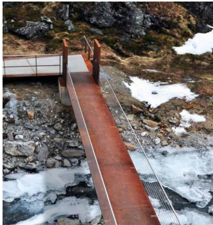
Døme på gangbru i CorTen-stål frå Trollstigen nasjonale turistveg.
