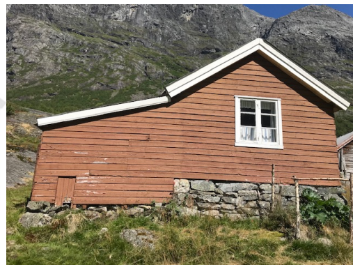
Skisse for planlagt utsjånad etter riving av gamal og oppsetting av ny kledning, utskifting av vindauget med småruta glas og ny rute i fjøsveggen mot sør. Biletet er frå dagens tilstand.
