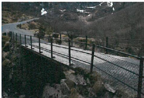
Fig. 3: Visualisering av ei ny bru (kjelde: Nordplan). Fig. 4: Dagens bru ved Kleivafossen med tredekke på ståldragarar og stålrekkverk (kjelde: Nordplan).
