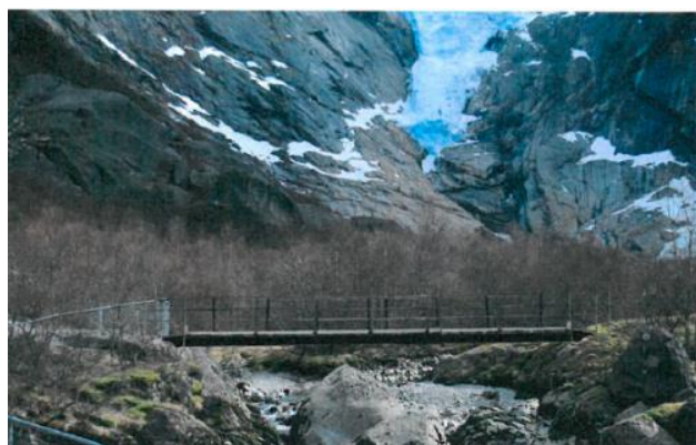
Fig. 3: Visualisering av ei ny bru (kjelde: Nordplan). Fig. 4: Dagens bru ved Kleivafossen med tredekke på ståldragarar og stålrekkverk (kjelde: Nordplan).
