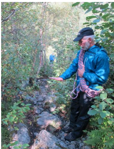
Fig. 10: Grenseskiltet til nasjonalparken er om lag der den blåkledde personen står i bakkant av biletet. Rune Myklebust i framgrunnen viser kor høgt ein omtrentleg må fylla på med masse for å vinne høgd, slik at gangvegen ikkje blir for bratt på svaberget på bilete 11. Fig. 11: Gangvegen er planlagt på det våte partiet til venstre i biletet. Bilete frå synfaringa.
