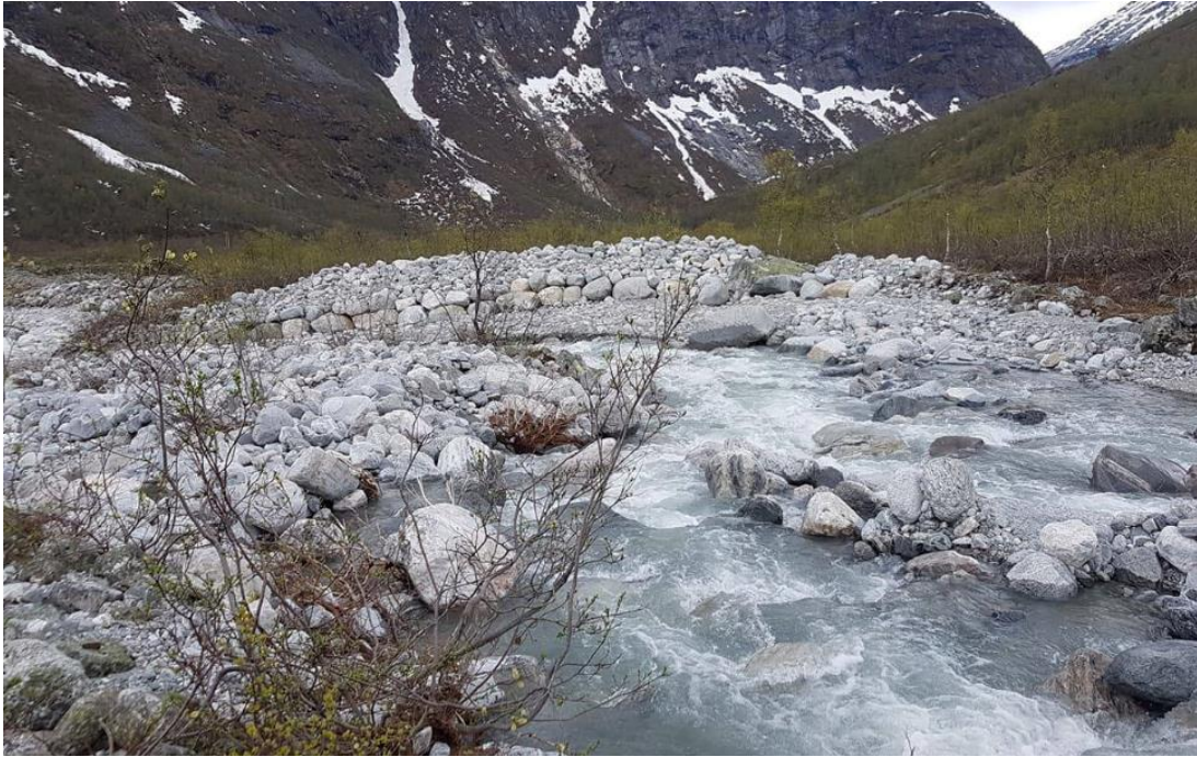
Figur 9: På bildet ser ein plastring/elveforebygginga frå våren 2019 langs elveløpet. Arbeidet er fullført og er innanfor vernegrensa.
