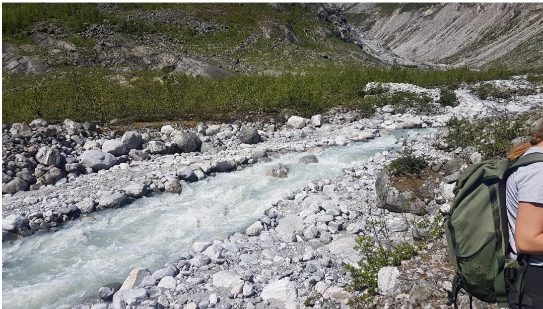
Figur 11: Omsøkt plastring langs elveleiet, men her er tiltaket ikkje gjennomført. I høgre bakkant av biletet ser ein den avlange plastringa inn mot bjørkeskogen.
