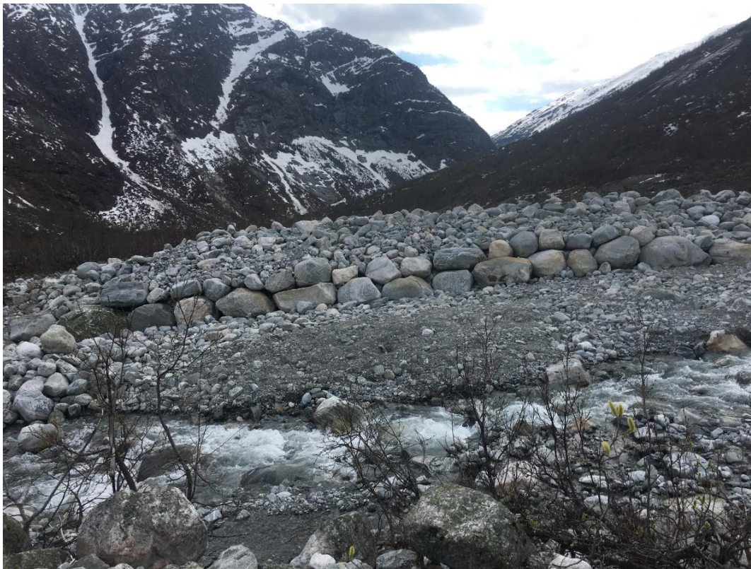
Figur 4: Delar av elveforbygginga innanfor vernegrensa
