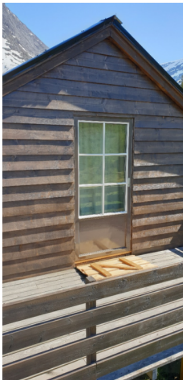
Figur 2 Vestveggen etter at dør er montert, med og utan forblending.
