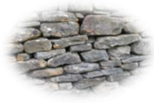
Figur 65 Forstøtningsmur med naturstein (boligsøknad, 2012).
