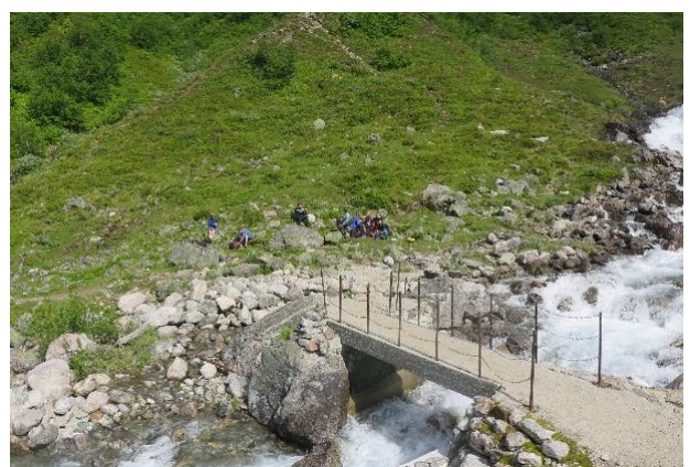
Figur 6.9. Sjinglebrua ved Fosdøla ble restaurert og forsterket i 2008 og skal nå tåle å utsettes for flom og ras. Rundt broa ligger det mye flomtransportert materiale fra tidligere flommer.
