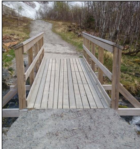
Figur 41. Et stort gap mellom broen og veien skaper problemer for enkelte brukergrupper. På bildet til høyre er grusen bygget opp mot broen slik at det flukter. Broen er laget bredere for å tilfredsstille kravene til universell utforming.
