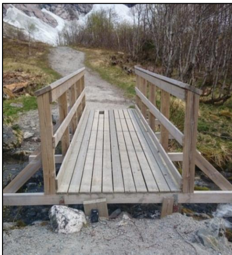
Figur 41. Et stort gap mellom broen og veien skaper problemer for enkelte brukergrupper. På bildet til høyre er grusen bygget opp mot broen slik at det flukter. Broen er laget bredere for å tilfredsstille kravene til universell utforming.
