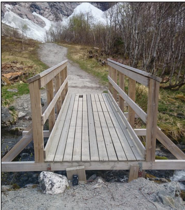
Figur 20. Trebroen er hevet 20cm over bakken
