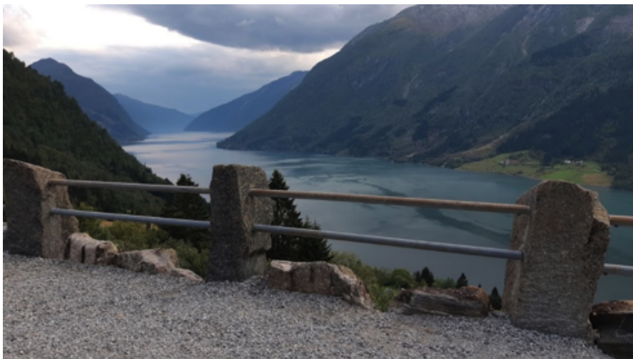
Figur 10 - Steingjerde med stålstenger på Berge i Fjærland.
