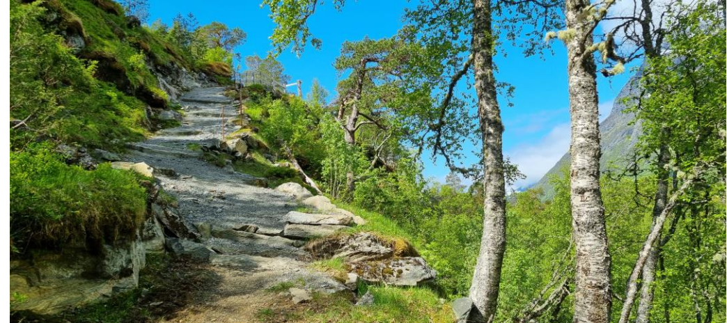
Tidlegare utført arbeid på kuråsa inn mot Sunndalssætra held bra
