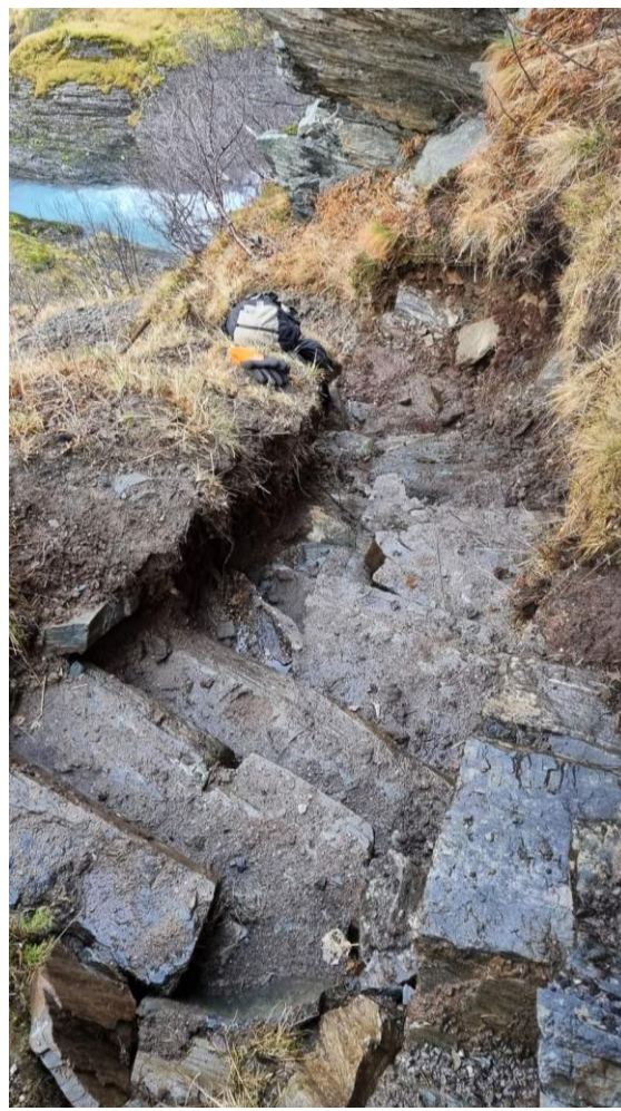
Etter utbetring der det berre er nytta stein låg i og ved stien. Foto: Rune Holen
