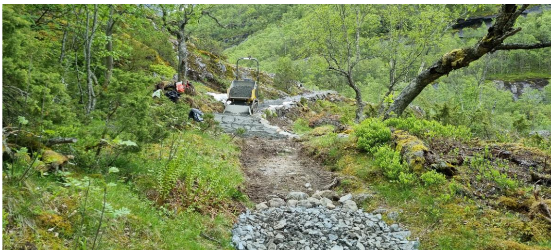
Mest mogleg av den opprinnelege steinmuren vart nytta ved utbetring av Keisar Wilhelmstien
