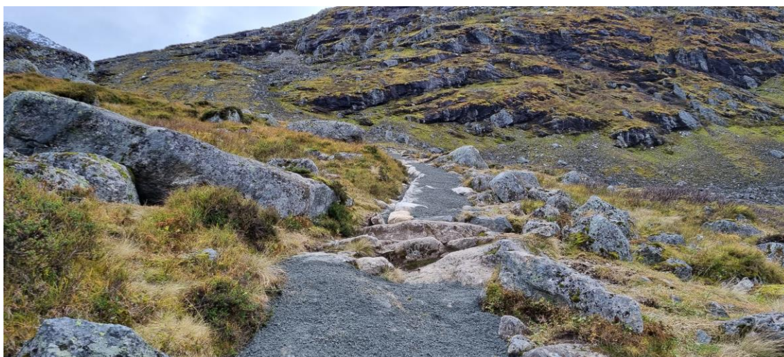
Døme på utbetring av stien til Skåla for å hindre vidare erosjon. Det er steinsett ei grøft og det er laga fleire steinbygde stikkrenner. I sti-kroppen er det påfyll av grus (knust masse)
