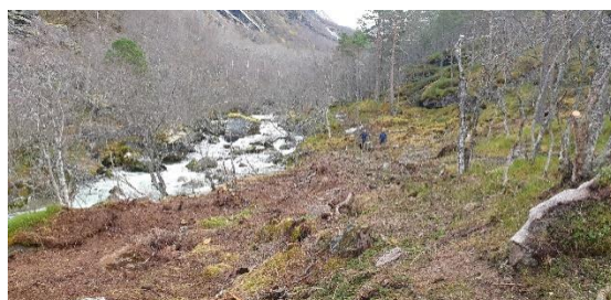
Godt arbeid utført av entreprenør langs stien inn mot Sunndalssætra
