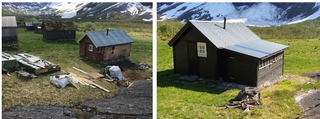
Kontroll av løyve gitt til restaurering av stølsbygning på Storesetra (Erdalsetra), undervegs og ferdig utført
