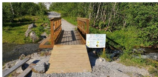
Oppbygging av rampe og vedlikehald av brua mot Bøyabreen
