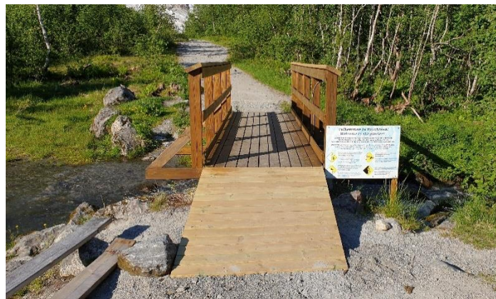
På veg inn mot Bøyabreen var ferdselsteljaren festa til den nyvøla brua
