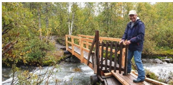
Einar Blikra viser fram det nye rekkverket på brua i Bergsetdalen
