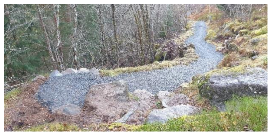
Delar av utbetningsarbeidet på Skålastien. I tillegg er det mura opp med stein i svingen
