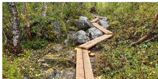
Klopplegging på våte delar av stien inn Bergsetdalen
