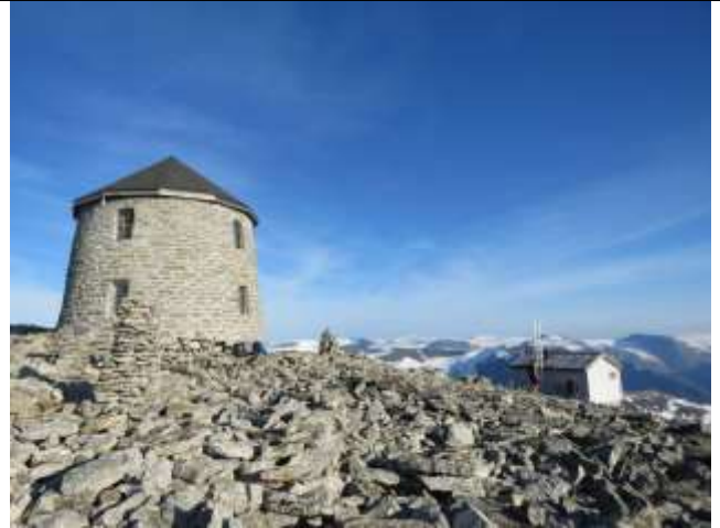
Bergen og Hordaland Turlag ynskjer å bygge eit avlastingsbygg ved Skålatårnet. Mogleg høgde på taket er vist med stigen.
