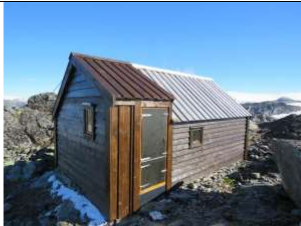
Sikringsbua Kvannebakkbua har fått ei utbetring med eit betre inngangsparti.
