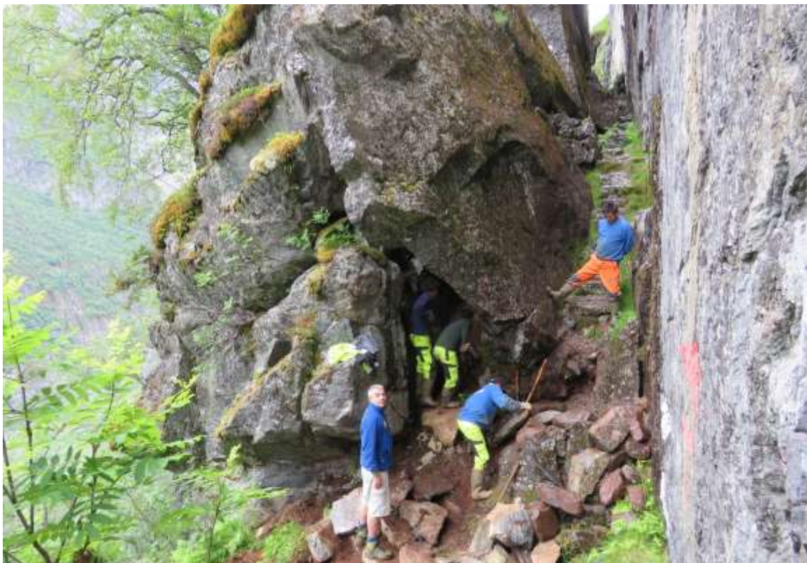
Arbeid på stien ved Gløvre i Oldeskaret. All steinen som vart brukt er henta frå nærområdet
