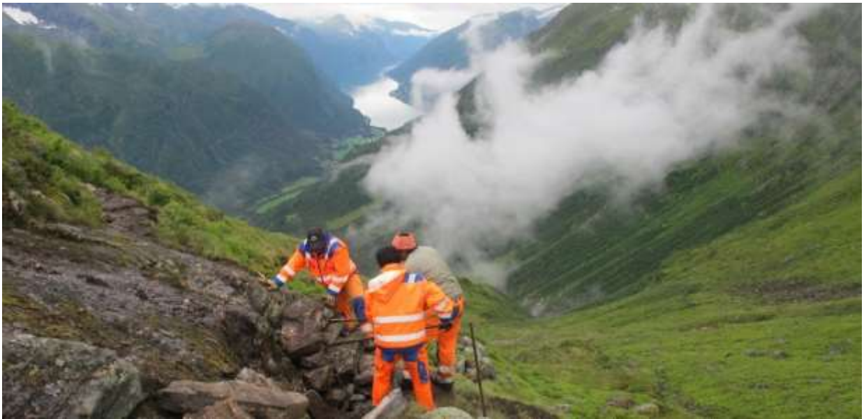
Tørrmuring av steintrapp opp eit bratt sva nær Flatbrehytta.
