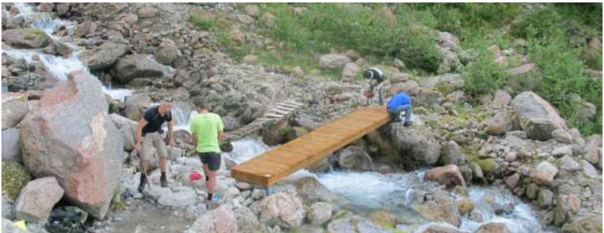
Fi ny og solid bru (to kraftige stålbejler er kledd inn) har kome på plass over Koppelvi på stien om Nipeskaret til Flatbrehytta.
