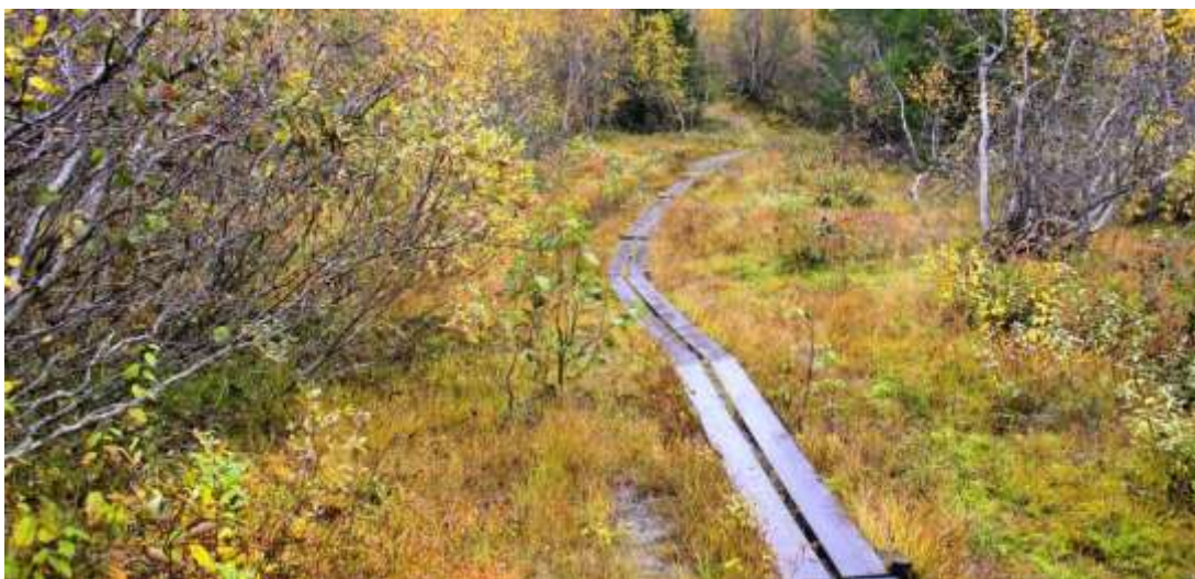
Godt etablert kavlelegging.
