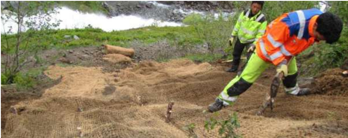
Kokosmatte er nytta for å hindre vidare erosjon ved eit utsett parti av stien
