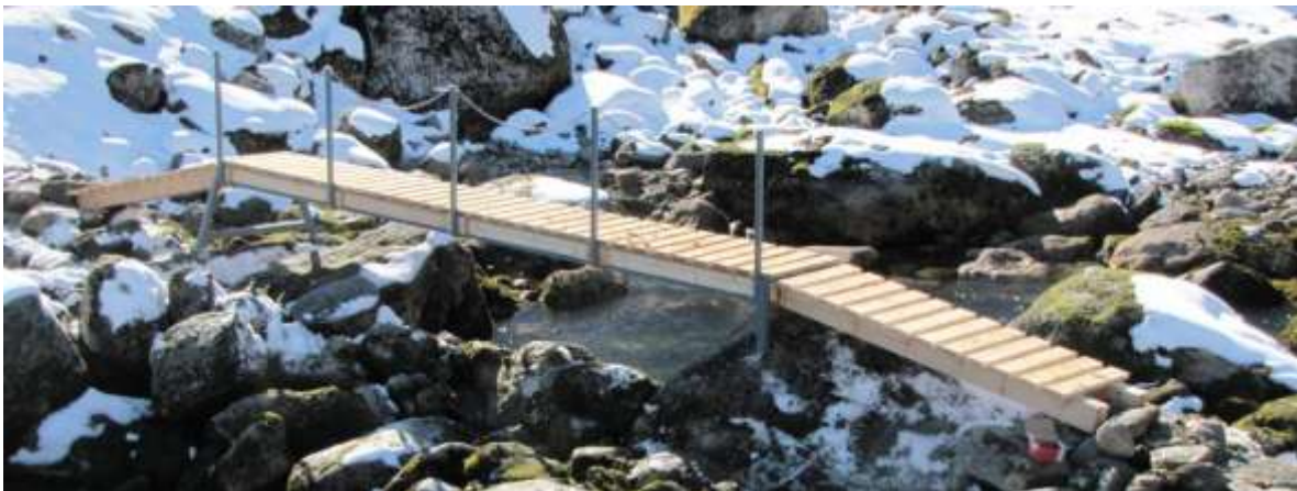
Brua i Oldeskaret vart flogge opp halvfabrikert frå bygda. Det er brukt H-bjelkar og kjerneved av furu.
