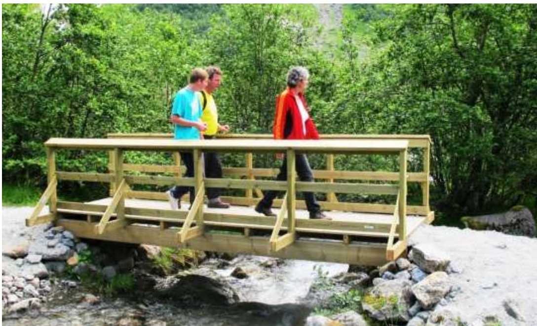
Den nye brua ved Bøyabreen
