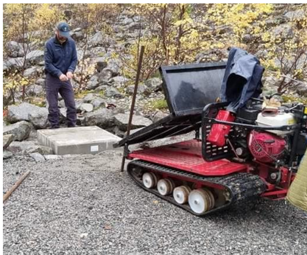
Fundament på plass for skiltet i Kjenndalen. Foto: Rune Holen
