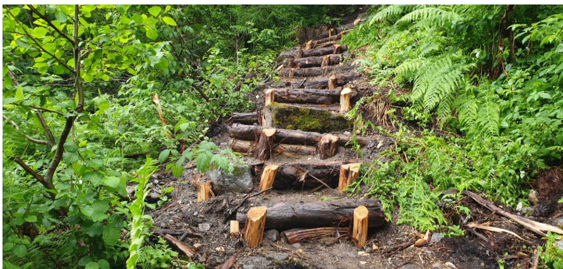
"Ei stitrap" er bygd opp av søyle-einer i den nedre bratte stigninga på stien til Flatbrehytta
