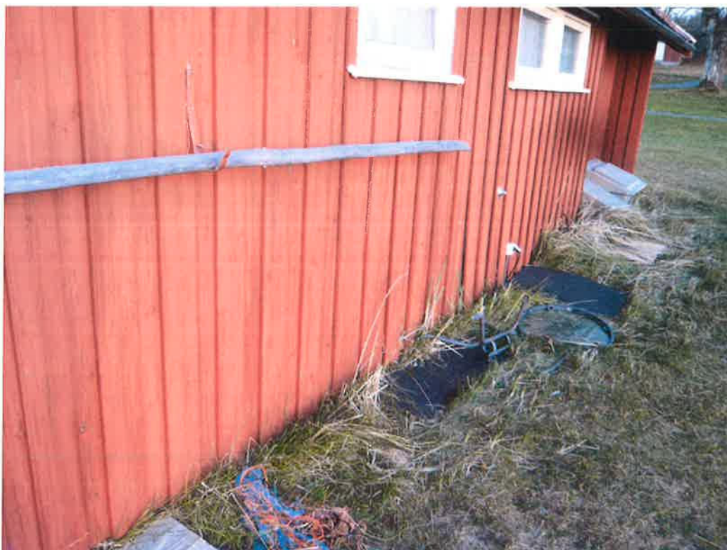
Utvendig kledning går ned i terreng.
