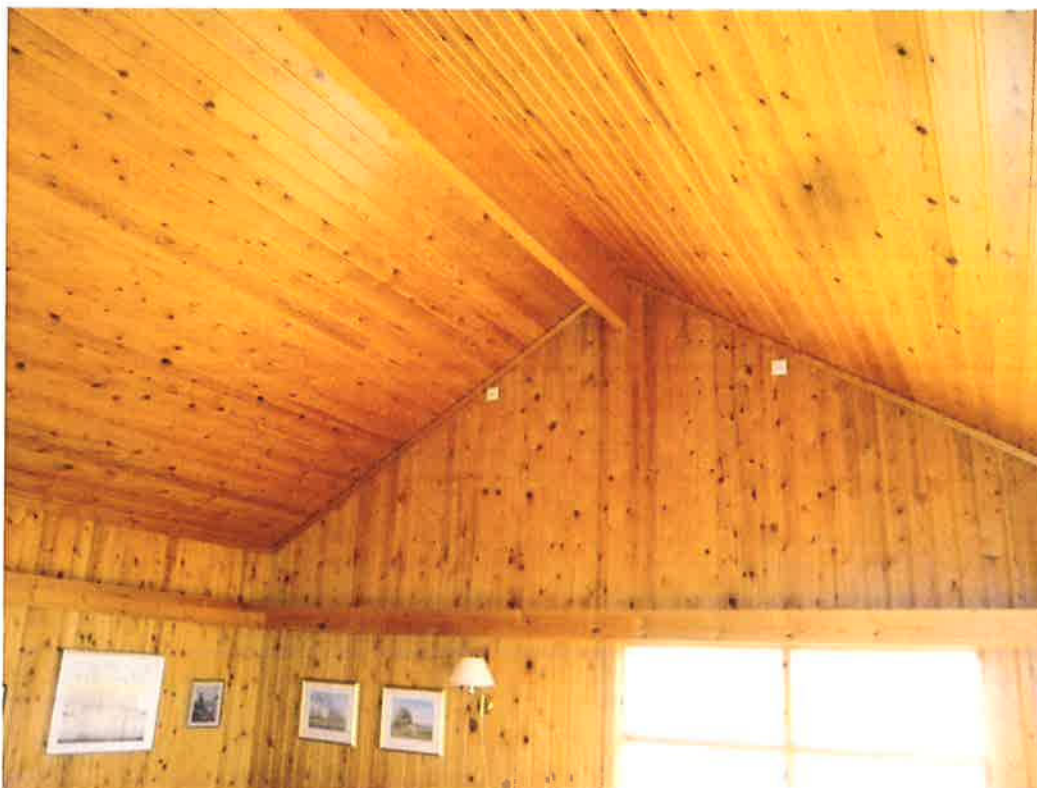
Skråtak oppbygget med limtre.
