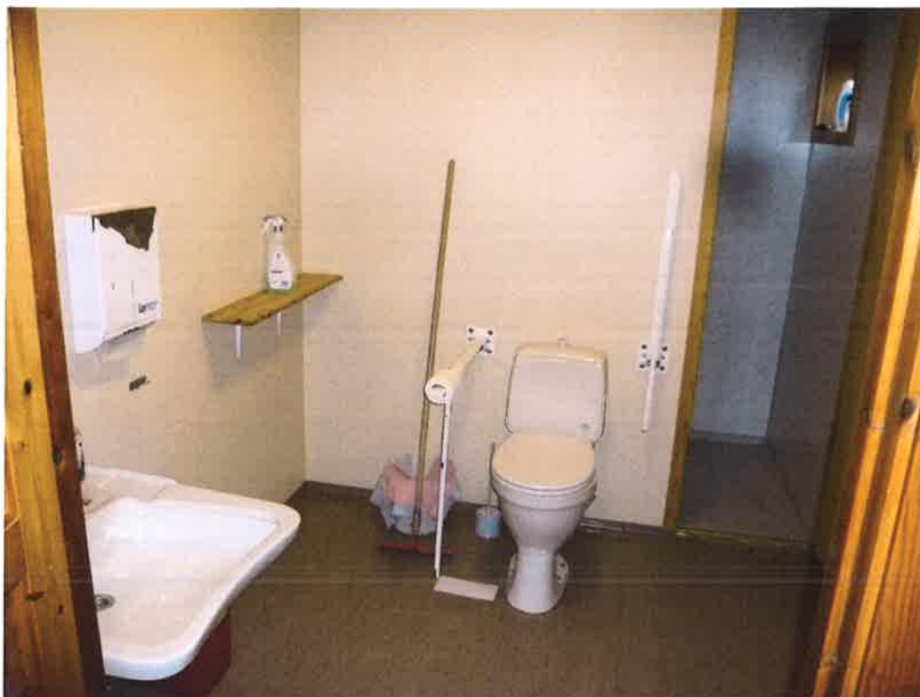
Toalettrom med dusjrom.
