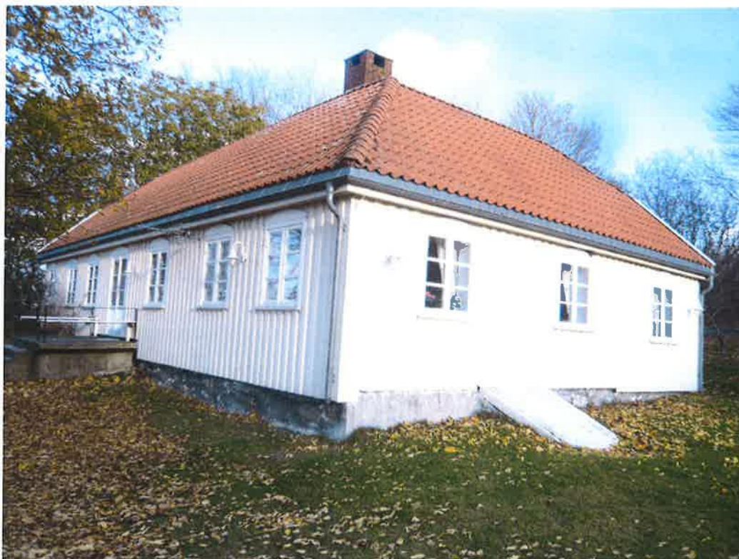
Terrassedør er av eldre årgang, med enkelt glass. Kjellerlem i tre.
