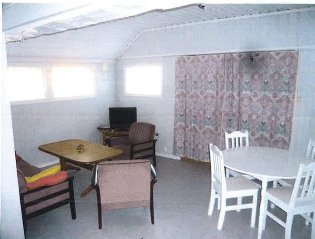
Innvendige overflater fra 2009 er i bra stand.
