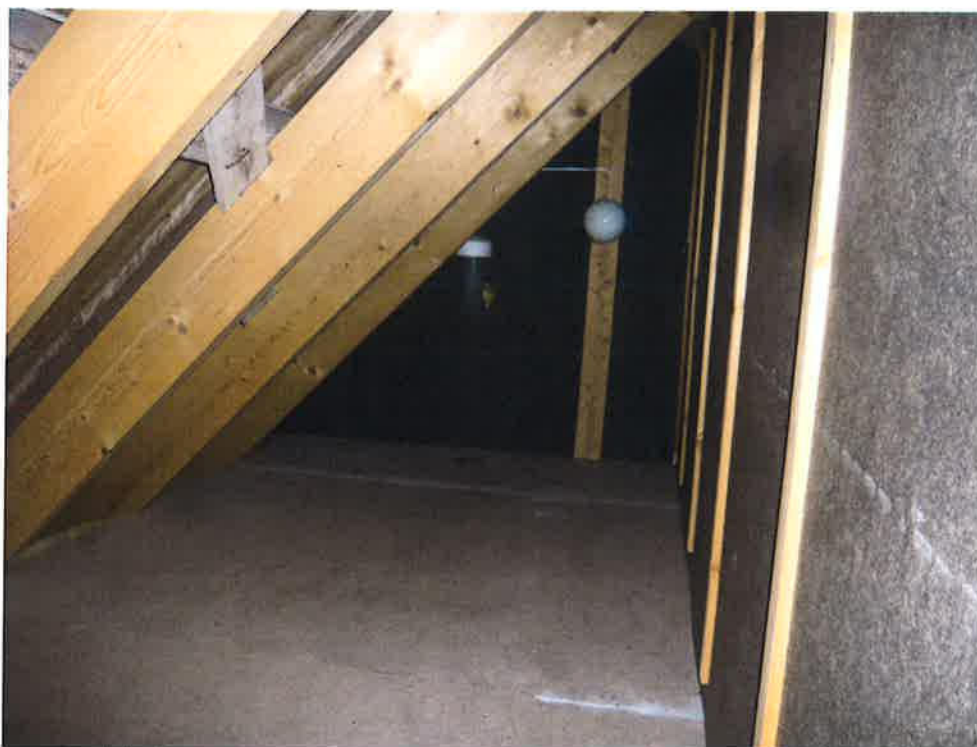
Kott er kledd med asfaltplater mot oppholdsrom.
