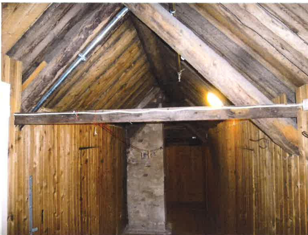
Gang i 2.etg. er i enkel standard. Ikke isolert.
