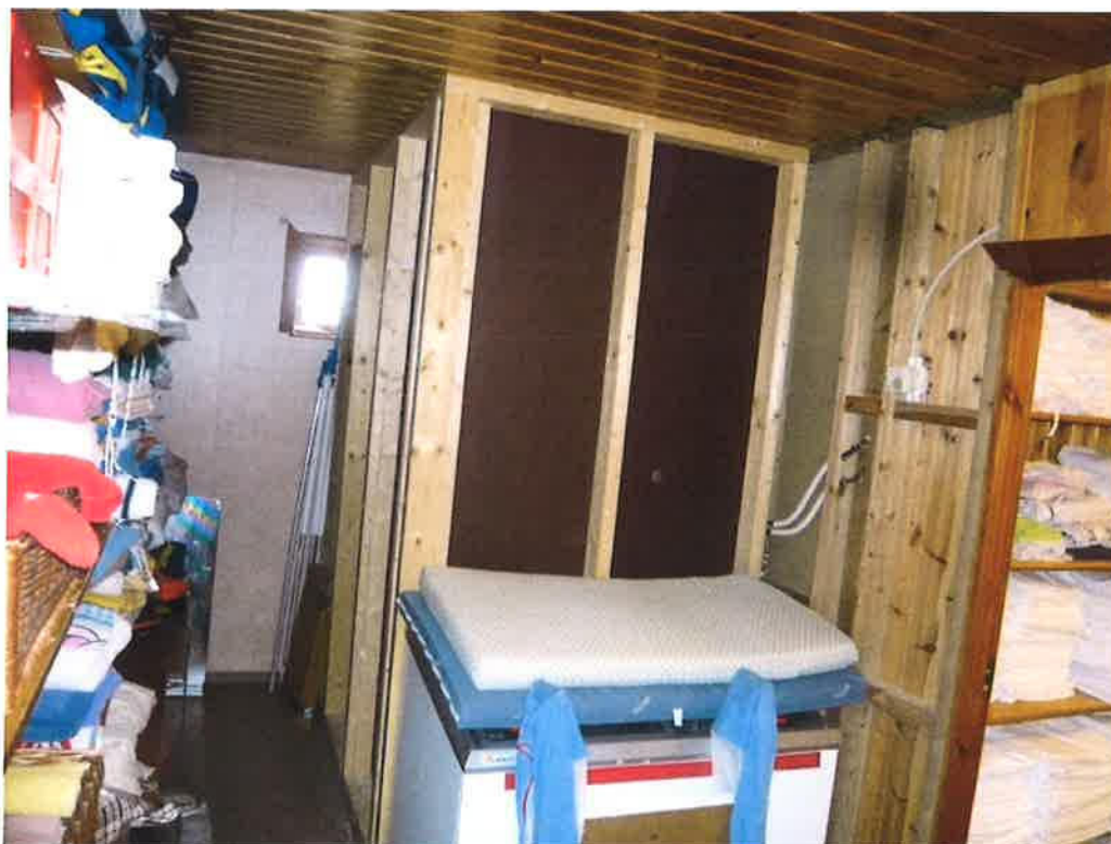
Lagerrom, ikke ferdigstilt.
