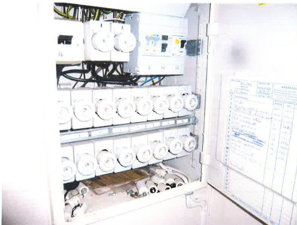
Sikringsskap i 1.etg. med skrusikringer.
