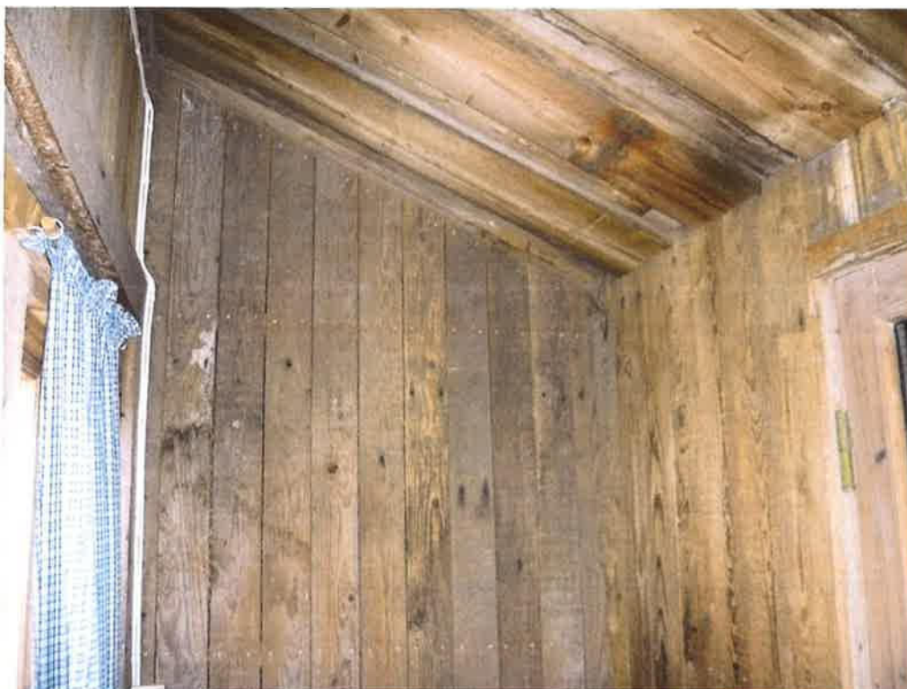
Yttergang er i enkel standard, med behov for oppgradering.
