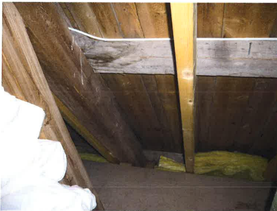
Takkonstruksjonen er noe forsterket og isolert i ca. 1982.
