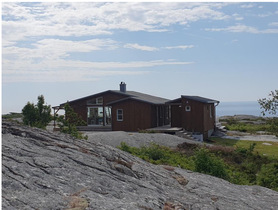
Hytte – fotoår 2023. Hytta har gjennomgått fasadeendringer og utvidelse i forbindelse med V/A-løsning. Foto: Jomfruland nasjonalparkstyre.
