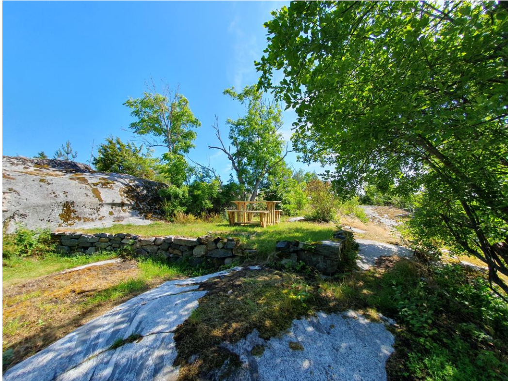
Foto tatt fra nord-vest som viser gammel grunnmur. Grunnmur hviler på svaberg. Fotodato 05.07.2023, Jomfruland nasjonalpark.
