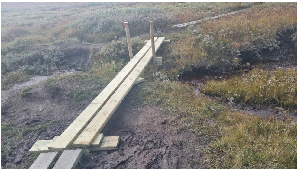
Litt lenger inn på myra ble det laget en klopp over gjørmete området. Foto: Petter Braaten
