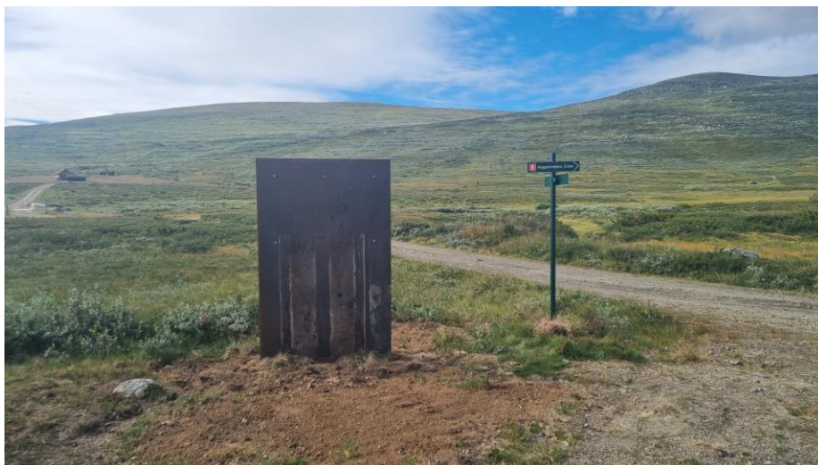
Viser cortenstålplate ferdig oppsatt. Foto: Petter Braaten
