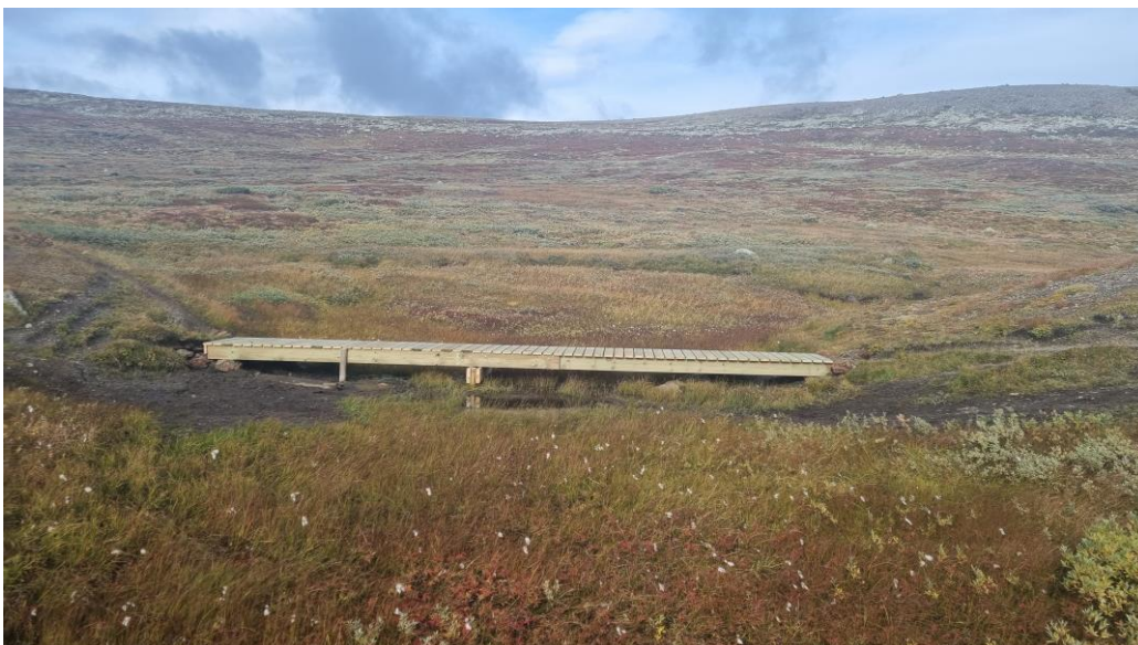
Brua er ferdig bygget og gjør at kryssing av det våte området nå er både trygt og tørt. Foto: Petter Braaten
