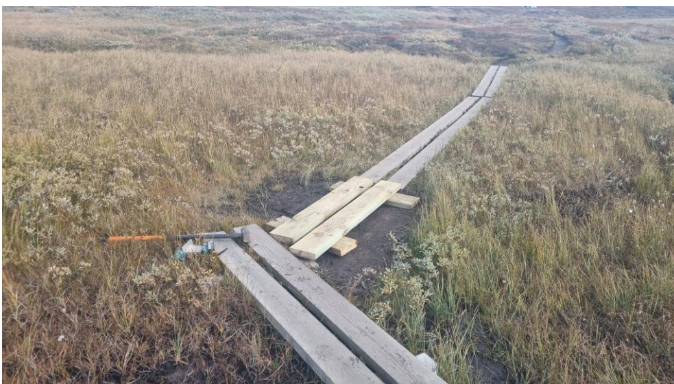
De gamle kloppene manglet noen meter som nå er på plass. Foto: Petter Braaten
