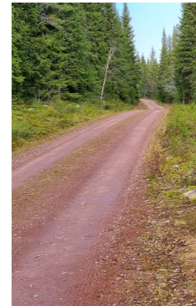
Grusvegen mot Bergådalen. Bildet viser eksempel på godt stabilisert grusdekke av lokal stein.
