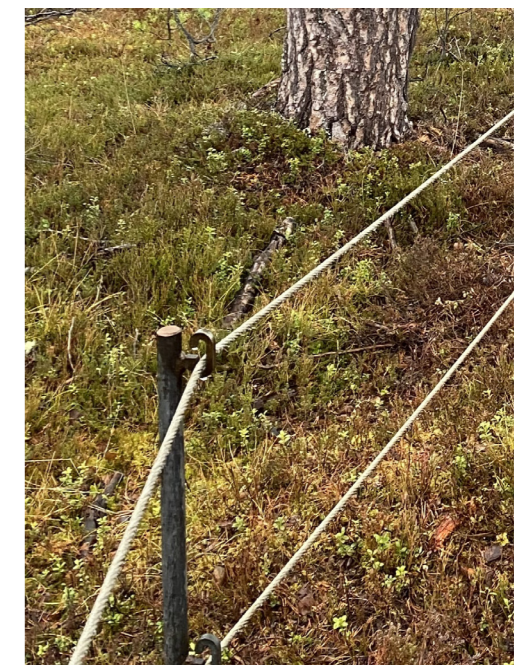
REFERANSE REKKVERK; STOLPER MED PÅSVEISET KROK FOR VAIER (foto; Eldrid Nedrelo)
