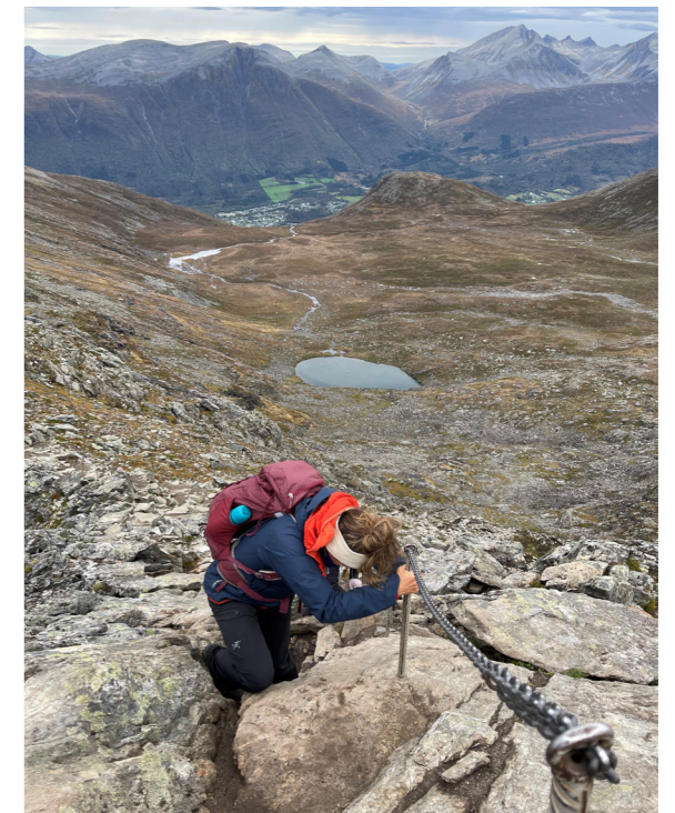
Referanse fra Romsdalseggen. Eksempel på stolper av råstål med håndløper av anker-kjetting.
