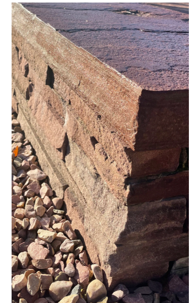
Natursteinsmur i lokal stein ved Gapahuken ved Storbekkasen
