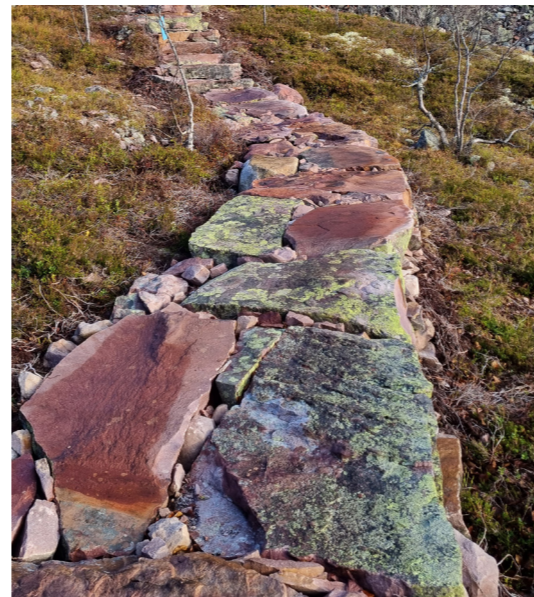
Bildet viser den nye sherpastien mot Brynsflået. Den er bygget av store blokker og natursteinsheller fra den lokale Trysilsandsteinen.
