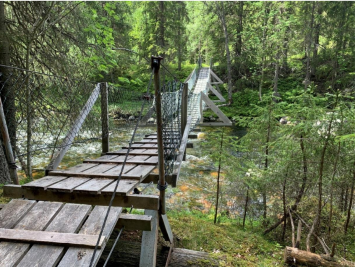
Figur 1. Bilde av privat hengebru over Bergåa, sett fra øst (foto Utmarksressurs AS).
