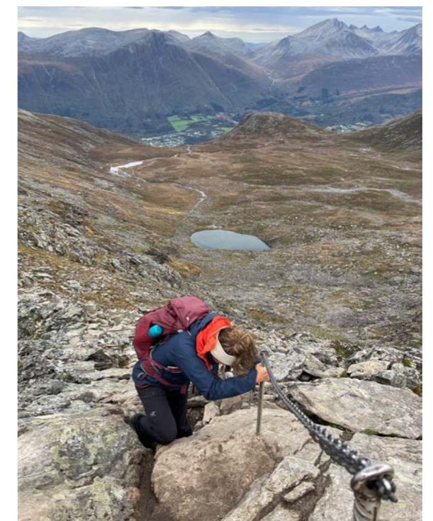
Referanse fra Romsdalseggen. Eksempel på stolper av råstål med håndløper av anker-kjetting.
