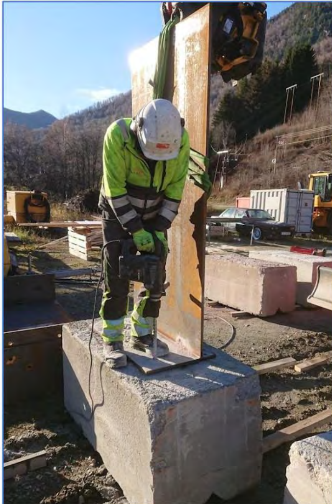
Figur 7. Betongfundament brukt til montering av cortenståltavlene. (Foto: Finn Bjormyr, Statens naturoppsyn).
