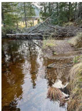
Figur 44. Bekk nedstrøms utløp stikkrenne 1400 mm.
