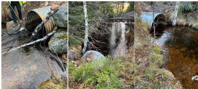
Figur 43. Bilder av stikkrenne 1400 mm.
