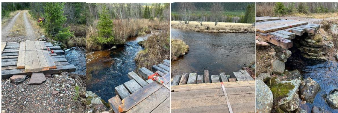
Figur 45. Bilder av bru med utløp til Ljøa.
