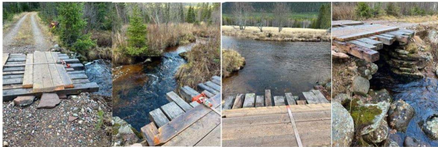
Figur 45. Bilder av bru med utløp til Ljøa.
