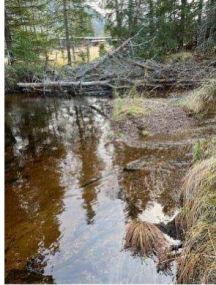
Figur 44. Bekk nedstrøms utløp stikkrenne 1400 mm.
