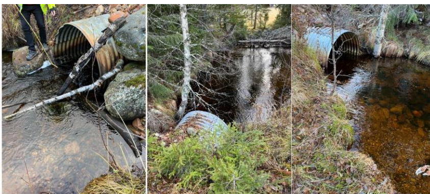
Figur 43. Bilder av stikkrenne 1400 mm.
