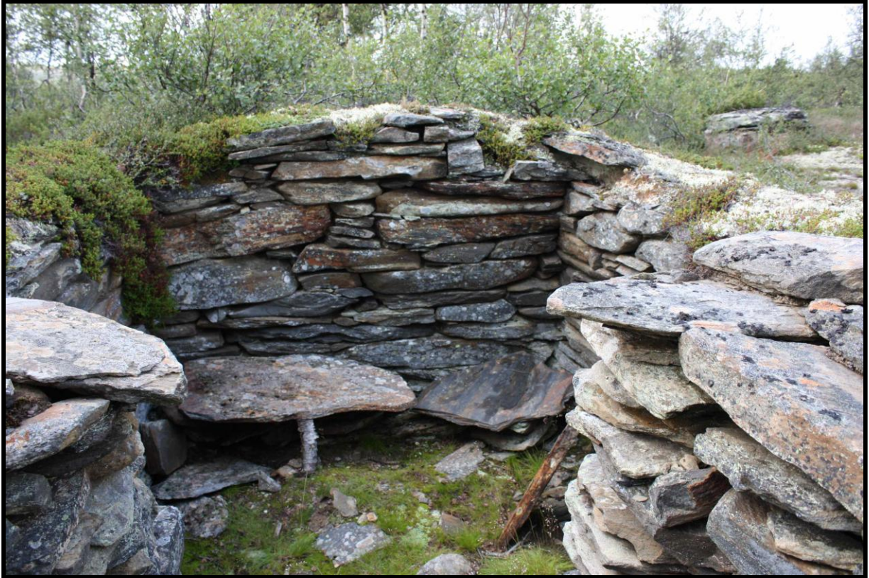
Figur 6 Oppstøttet helle i den murte kjelleren. Foto: AHS
