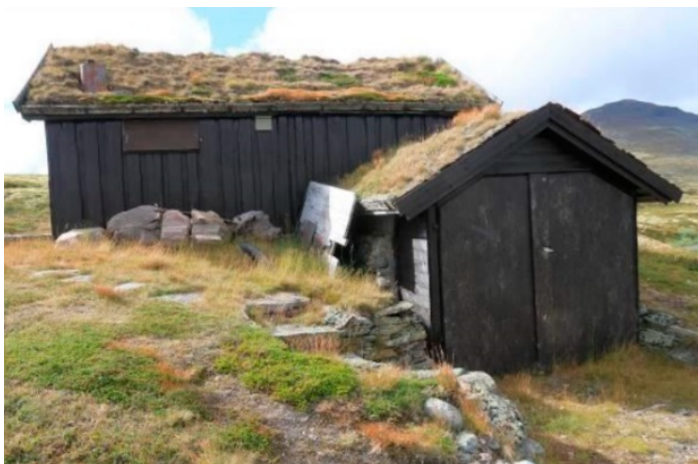
Figur nr. 9: Illustrasjon av nødvendig terrengbearbeiding – sammenbygd bu og naust i ulik terrenghøyde.
