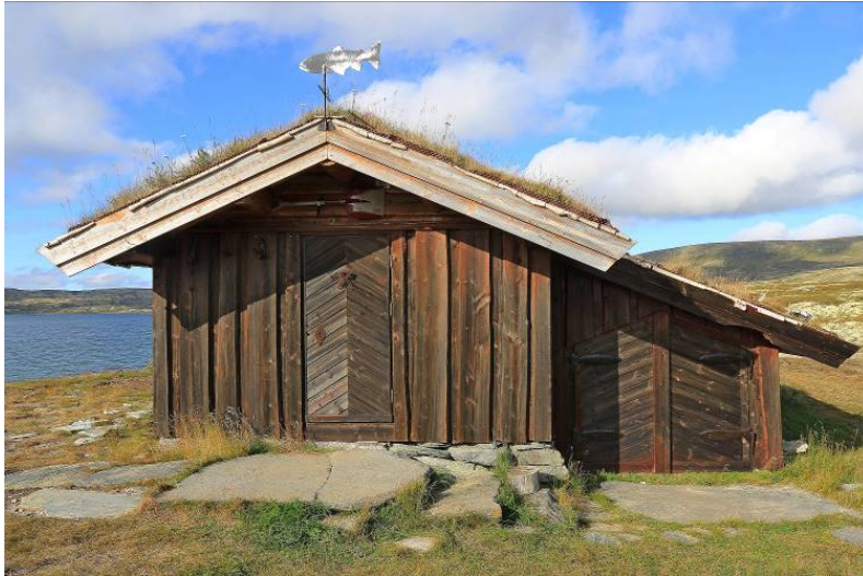
Figur nr. 12: Eksempel på bruk av ulik størrelse for å bryte takflaten mellom sammenbygd bu og naust.
