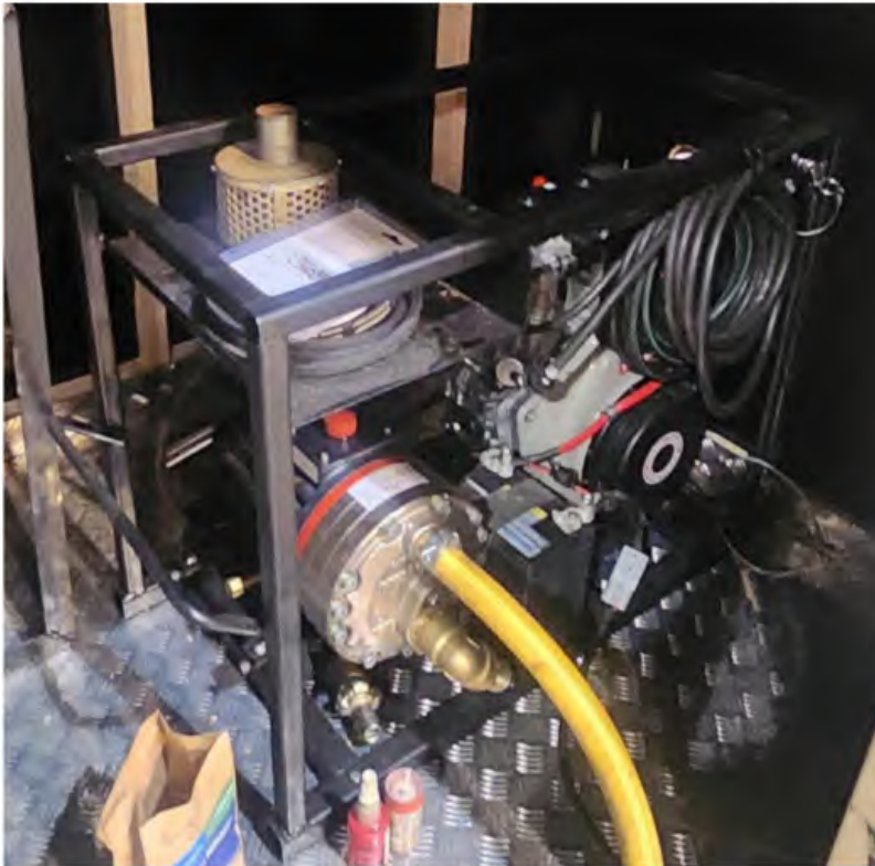
Figur 3: Arctic Drilling sitt utstyr som brukes for å pumpe vann til bore-riggen. Det kobles en vannkabel fra vannpumpa til bore-riggen
