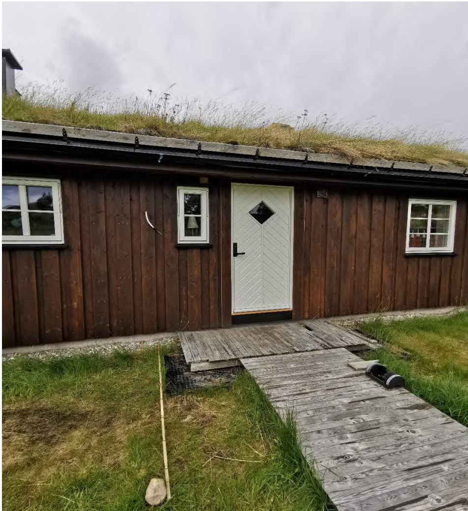
Figur 3. Bilde av front av seterstue. Tatt på befaring 12/07/23, blå teip marker bredde på søkt takoverbygg, og tommestokk utstikk fra vegg.
