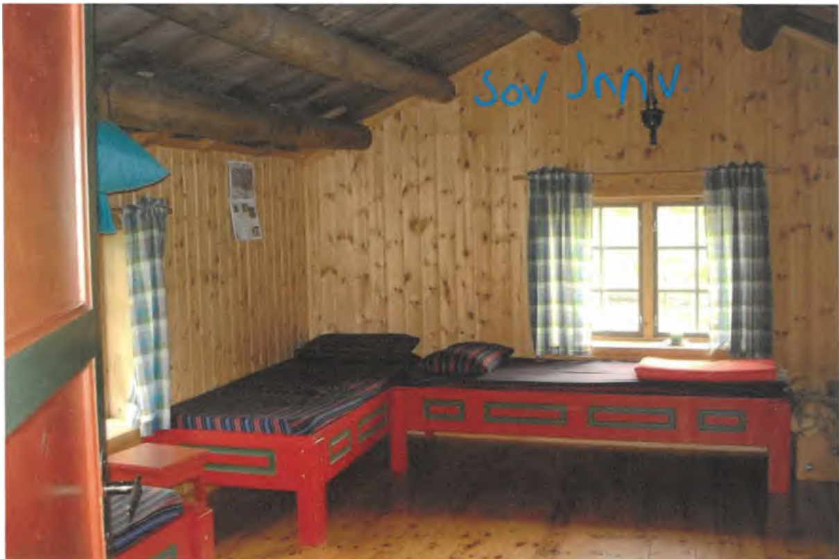
Innvendig situasjon av den vestlige tømmerkassa som søkes revet og erstattet.
