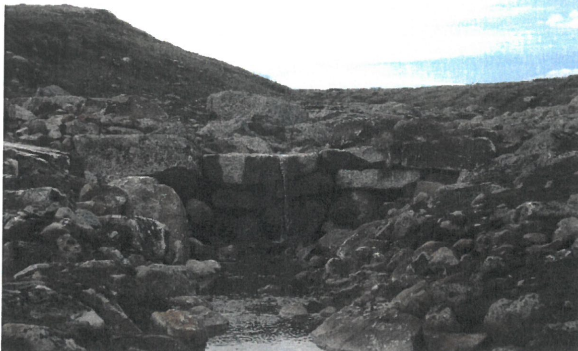
Fiskesperre fra Hardangervidda bygget opp av stein fra stedet. Foto Gry Walle FMVE.
