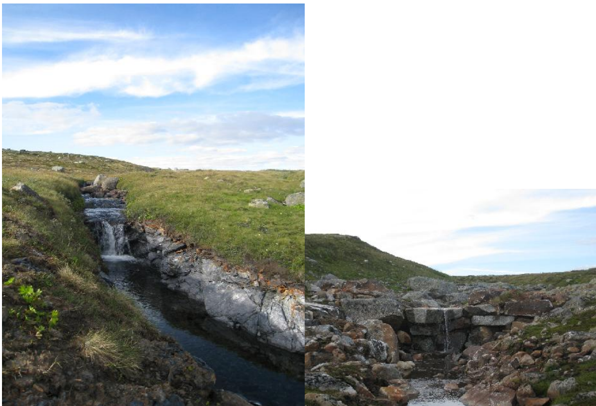
Figur 9 Eksempler på sprengt sperre og oppmurt sperre på Hardangervidda. Foto: Gry Walle FMVE
