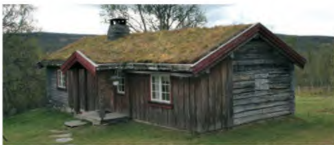
3. Seterstua på Stornorstuvollen i Ørvilldalen har fått et mindre takoverbygg over inngangen, men trappa er beholdt i naturstein.
