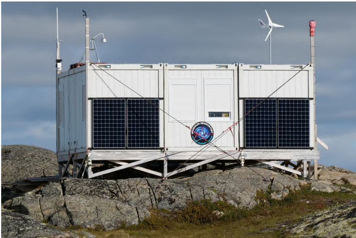
Figur 2: Bilde fra befaring i området 05.09.2022. Det vises til vurderinger gjort av bygningsmassen i ST-7/2025.
