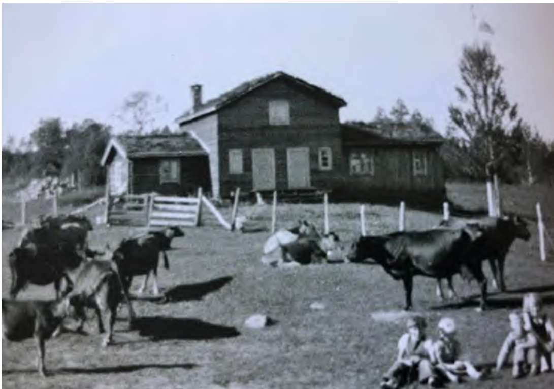
Døra til venstre på midtdelen som førte rett inn på kjøkkenet ble tatt bort på 1980-tallet, og et større vindu erstatter døra og det lille vinduet for å få inn mer lys i kjøkkenrommet. Bildet er hentet fra Osboka, bind 1.
