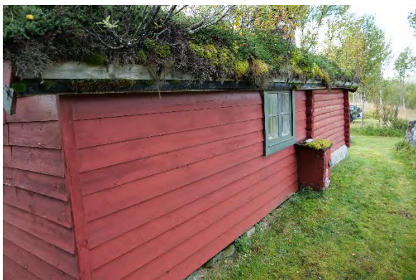
Figur 7: Bilder fra befaring, fasade nord fra dagens seterhus.
