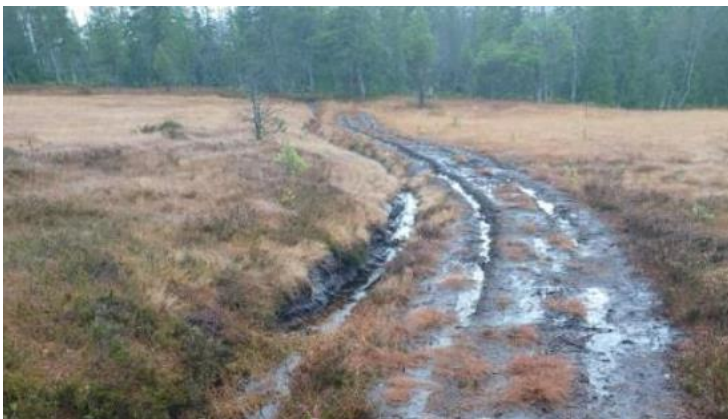
På flere punkter/strekninger langs traseen er det grøfter som skjærer gjennom myr.
