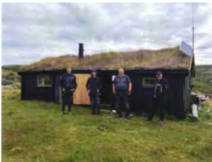
Bilde av vestsiden av bu med mannskap som deltok i oppstart av restaureringsarbeidet sommeren 2024.
