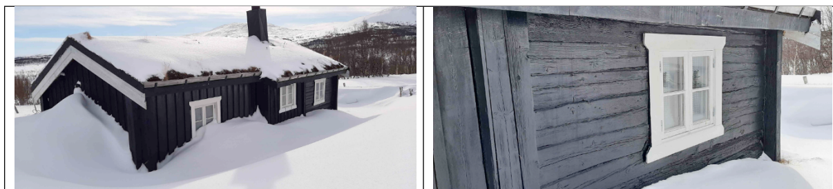
Vestvegg og nordvegg (del av vestvegg i tømmer)
