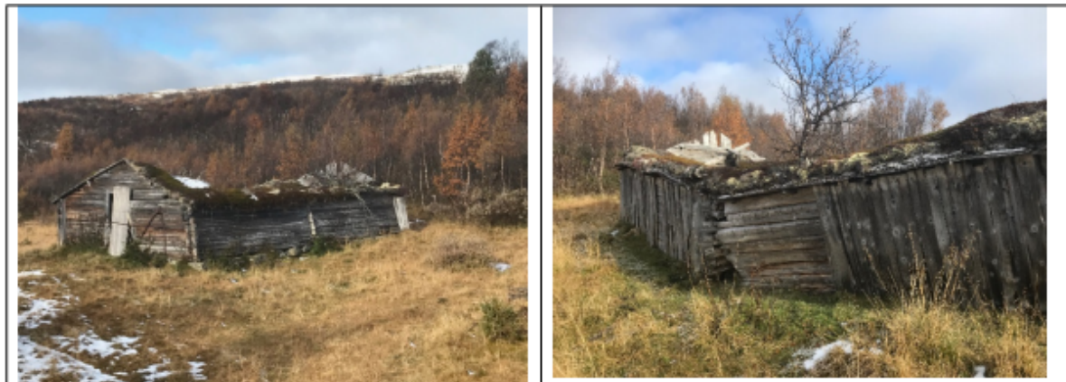
Figur 1: Bilder av eksisterende seterfjøs fra styrevedtak av 29. november 2019
