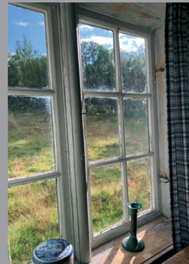
Dette vinduet i rokokkostil fra 1700-tallet bærer preg av å være gjenbrukt. Rammene er hengslet på midtposten og karmen skrå oppover i overkant.
