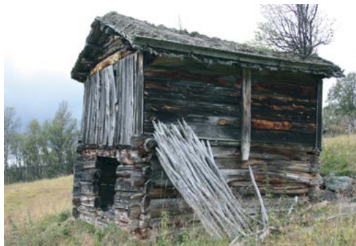
Løe i to etasjer, Nygardsvollen i Vangrøftdalen. Underdelen er i tømmer, mens øverdelen er i grovt bindingsverk
