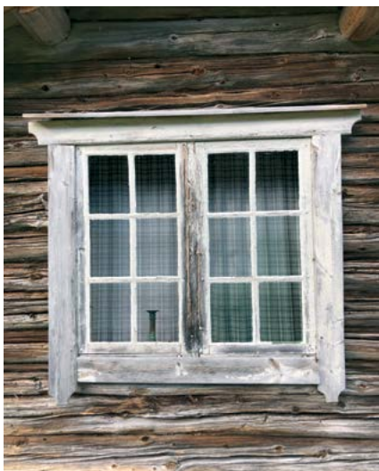
Eksempel på vindusomramming med inspirasjon fra sveitserstilen.
