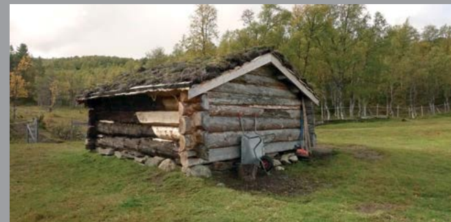
Reparasjon av tømmervegg, Bruavollen i Synnerdalen
