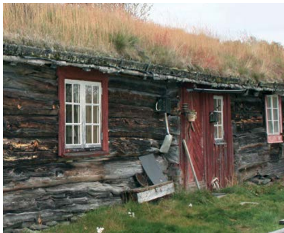
På Tollefshagenvollen i Svartåsen er det montert ei lita takrenne over skjælporten. Den er akkurat lang nok til å hindre takdrypp i nakken og på trapphylla.
