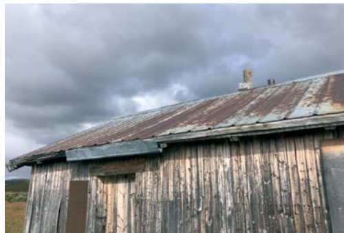
Denne gamle seterstua ved Grønntjønna har tak med kledning av stålplater med fals.
