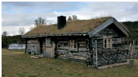
På ei anna seterstua på Hiåvollan i Endalen er det brukt pipe med stålbeslag.
