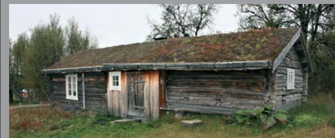
Nytt panel av god kvalitet kan gjerne stå ubehandlet. I løpet av to til tre år vil det få samme patina som de værbitte tømmerveggene.
