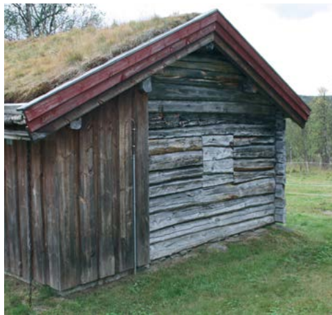
Takutstikkene er knappe, bare 15-25 cm, noe som gjelder for alle seterdalene rundt Forollhogna. Dette har sammenheng med at torv er et svært tungt tekkemateriale. I tillegg har vi et tørt klima hos oss. Det er derfor ikke behov for større takutstikk. Over innganger kan vi se at det enkelte steder er lagt korte takrenner av tre. Ellers er ikke takrenner vanlig, og bør derfor unngås.
