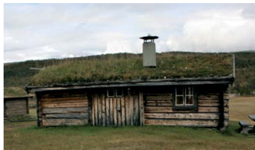
I denne seterstua på Hiåvollan i Endalen er det satt inn ei pusset elementpipe.
