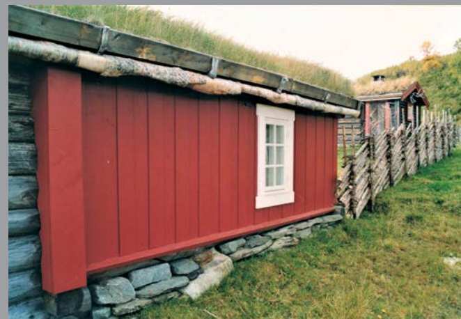
På Tollefshagenvollen i Svartåsen er det montert ei lita takrenne over skjælporten. Den er akkurat lang nok til å hindre takdrypp i nakken og på trapphylla.
