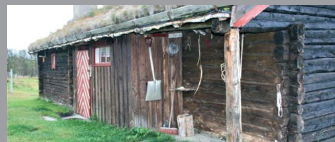
Vedtekje i Mastukåsen, Vangrøftdalen
