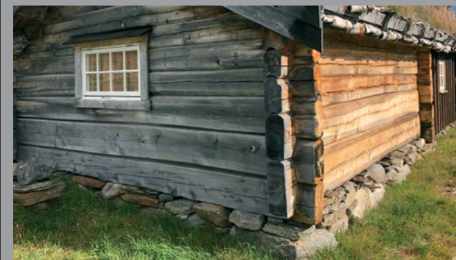
2. Den nyere, resturerte delen har fått samme type fundamentering.
