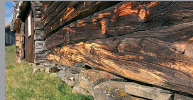
1. Seterstua på Hanshusvengen på Kvikne kan stå som et eksempel på god restaurering. Den gamle delen har holdsteinsmur, og denne er beholdt uendret.
