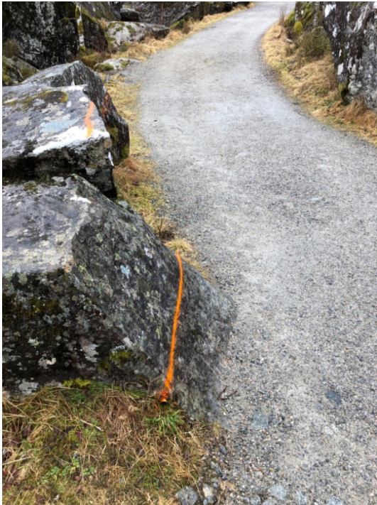
Søkjar har spraya der dei ønskjer å sprengje vekk stein i vegbana.
