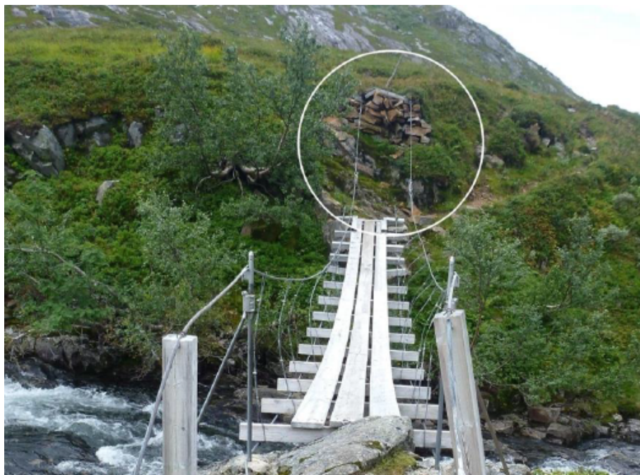
Ei skikkeleg vøla er nødvendig. Brufestet i ringen er kollapsa, så brua er farleg ustabil. Fleire tverrbjelkar er brotna og vaierane er skadde.
