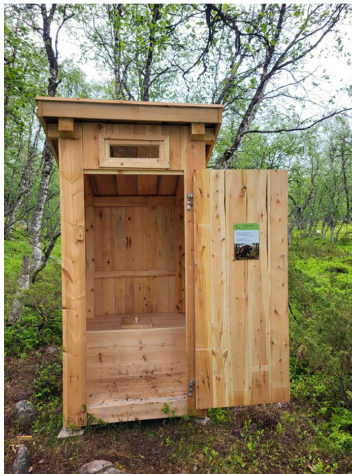
Ved Røosen er det satt opp to nye utedoer. Dette har gjort at doavfall ikke lenger etterlates i terrenget, og området fremstår nå betydelig renere og mer trivelig for besøkende.
