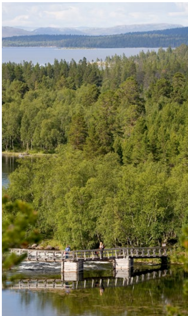
Gangbru over Røa. Foto: Jan Nordvålen
